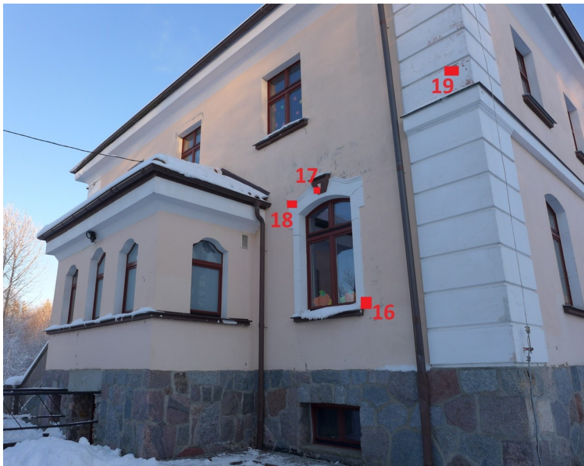
Elewacja zachodnia. Zaznaczono miejsca wykonania odkrywek sondażowych.
