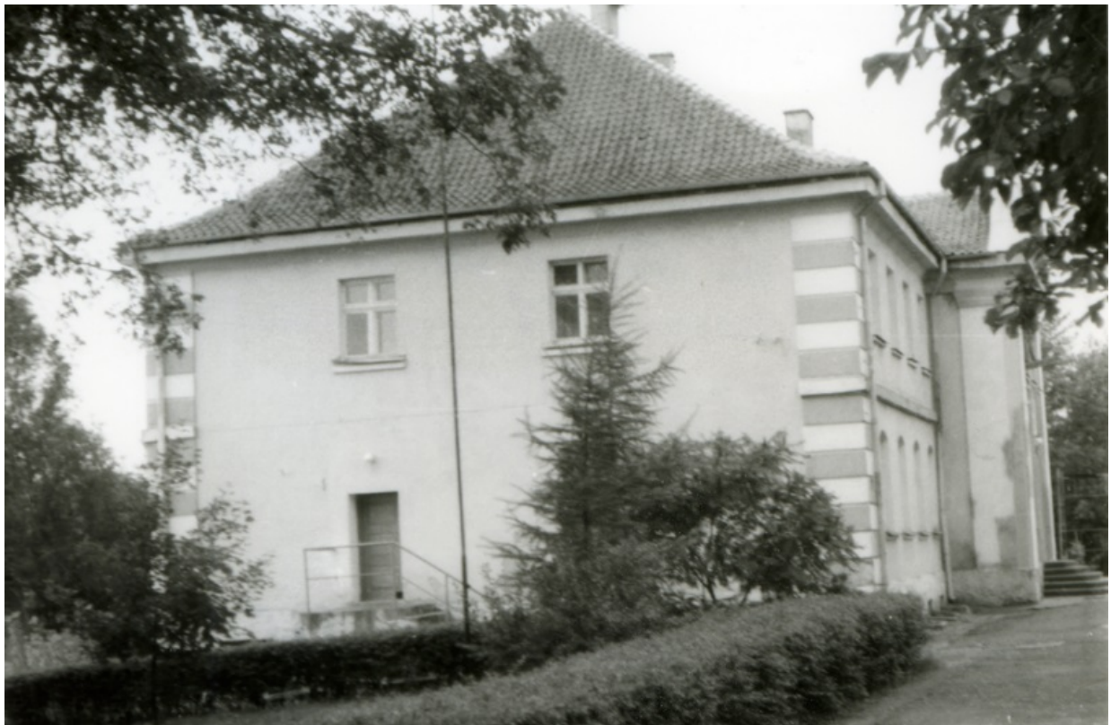
Widok na elewację wschodnią, nowe otwory okienne i otwór drzwiowy, nowa forma gzymsów.
