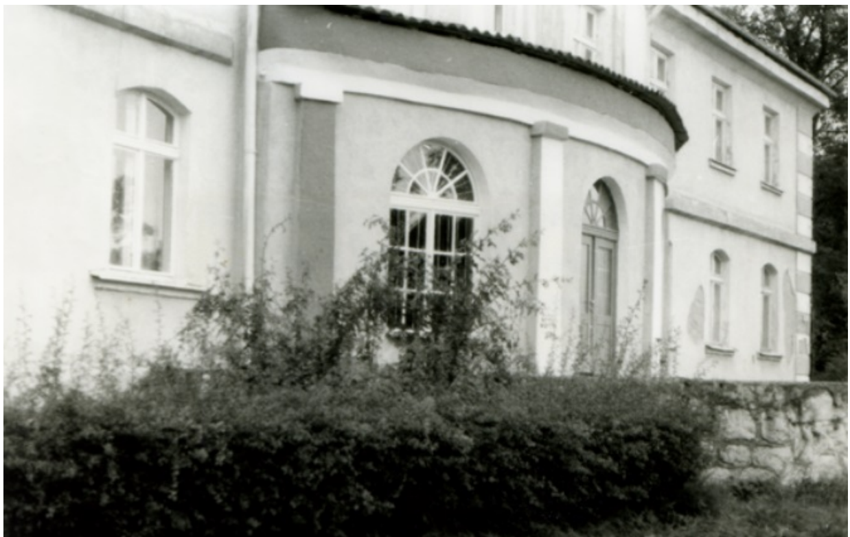
Widok na elewację południową, nowa stolarka okienna, brak boniowania, opasek okiennych, uproszczone kapitele, brak ciągłego gzymsy pod oknami I piętra.
