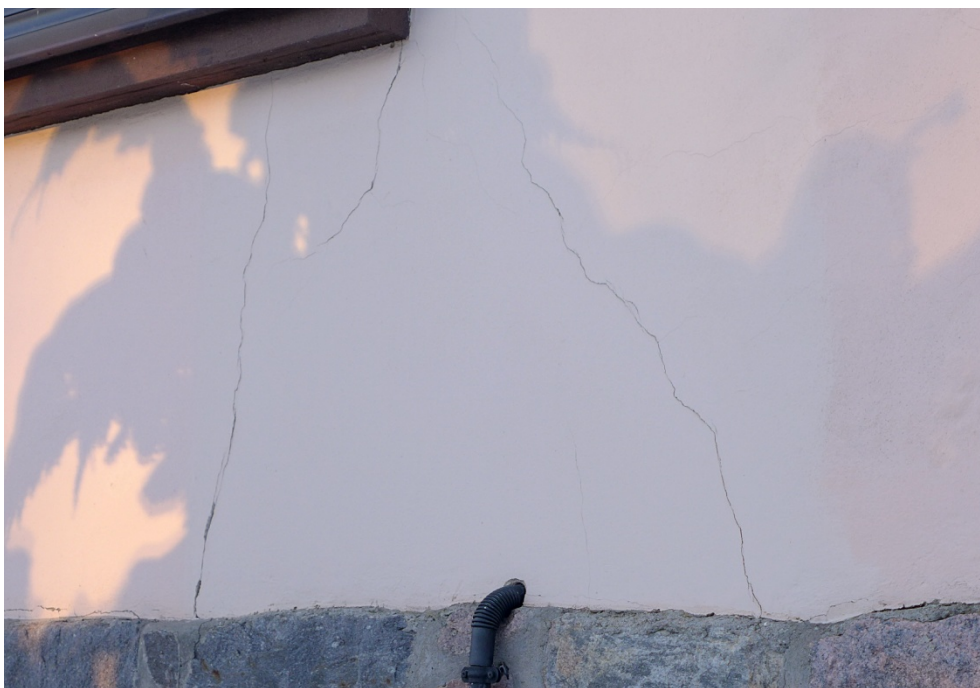
Fot. 8. Zagaje, elewacja wschodnia, widoczne rozległe spękania strukturalne muru w strefie parteru nad cokołem.
