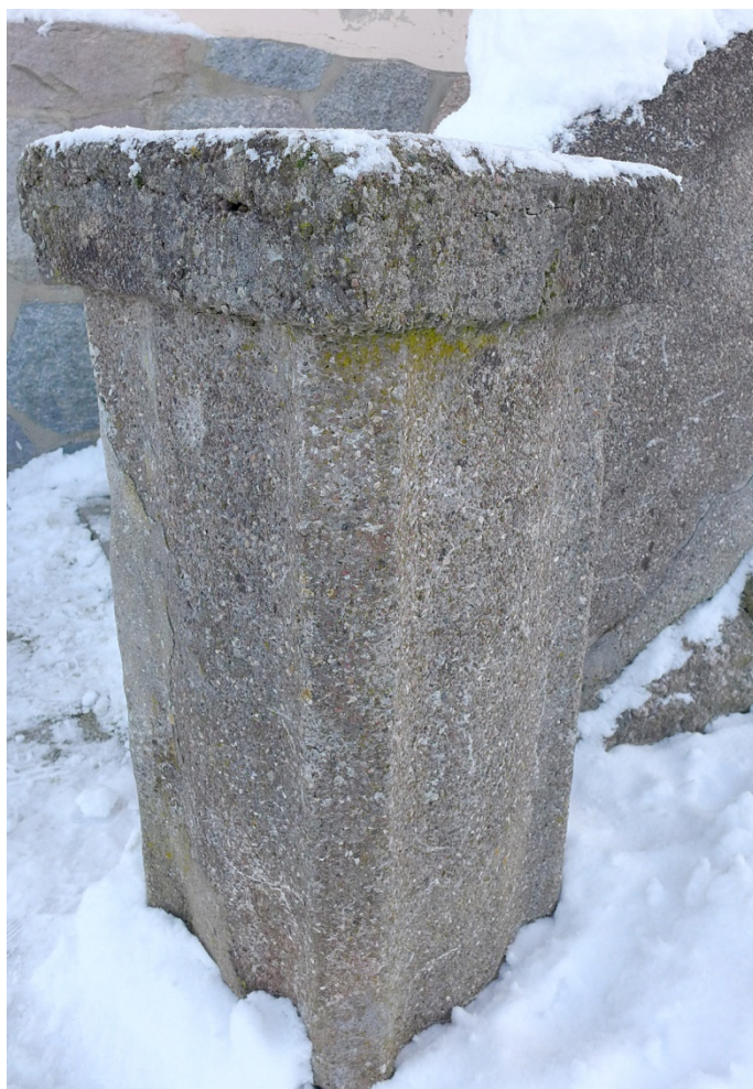
Fot. 12. Zagaje, elewacja zachodnia, widoczne ozdobne krzywoliniowe opracowanie słupa balustrady wykonane z lastryko.
