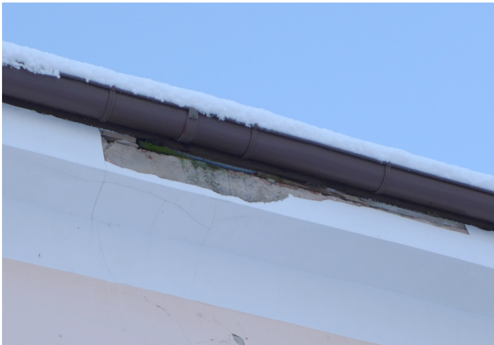
Fot. 7. Zagaje, elewacja wschodnia, widoczne uszkodzenia gzymsu wieńczącego, odspojenie wierzchnich warstw tynkarskich.
