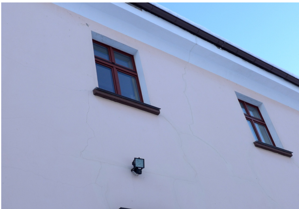
Fot. 6. Zagaje, elewacja wschodnia, zbliżenie pokazuje spękania strukturalne muru biegnące przez gzyms przez całą elewację.
