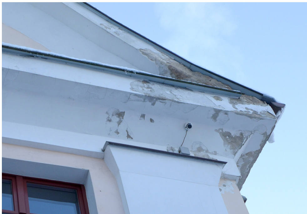
Fot. 3. Zagaje, elewacja północna, widoczne rozległe uszkodzenia zapraw na gzymsie centralnego ryzalitu, spowodowane nieuszczelnością obróbek blacharskich.
