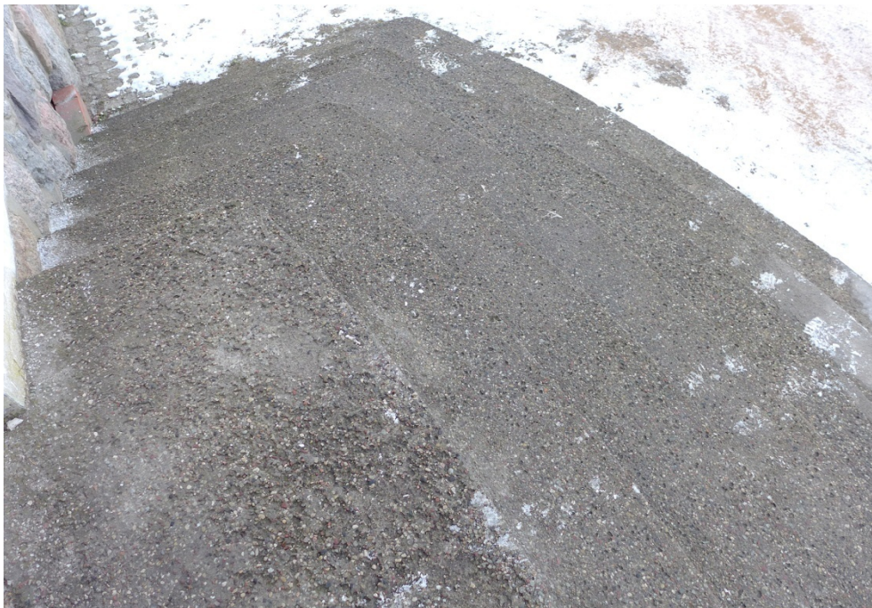
Fot. 5. Zagaje, elewacja północna, zbliżenie pokazuje głębokie wżery – ubytki kamieni w masie lastrykowej.
