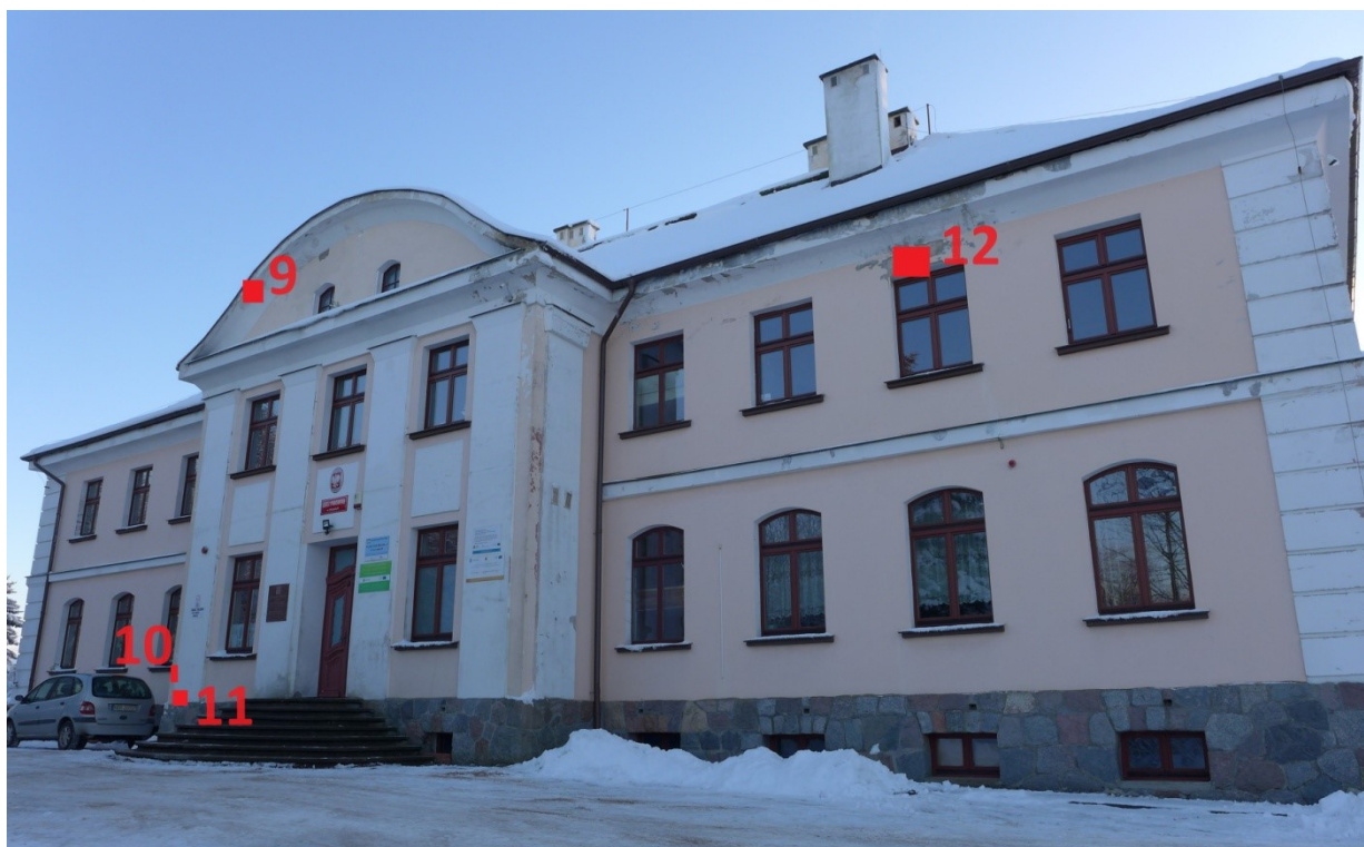
Elewacja frontowa – zaznaczono miejsca wykonania odkrywek sondażowych.
