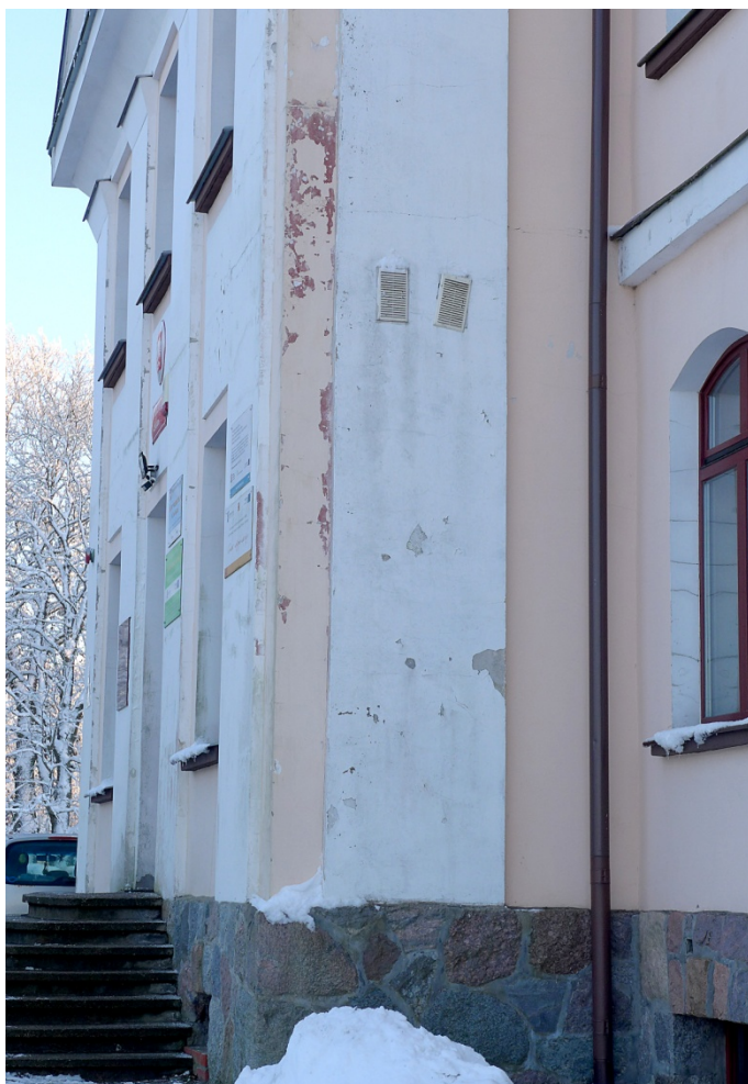
Fot. 2. Zagaje, elewacja północna, widoczne odspojenia nawarstwień na tle elewacji i pilastrze.
