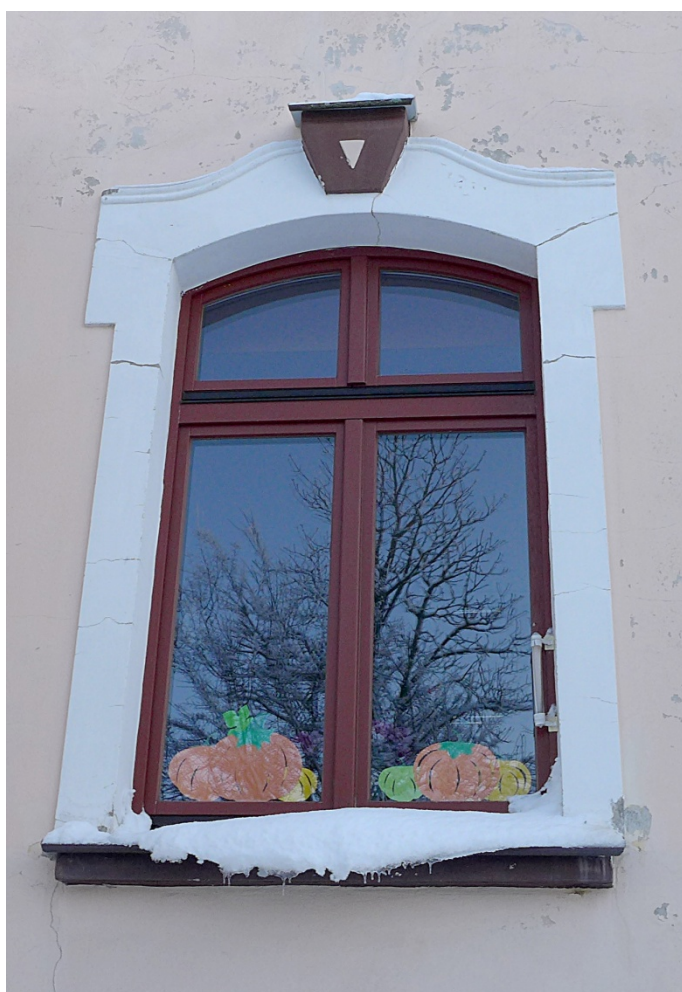
Fot. 10. Zagaje, elewacja zachodnia, widoczne włosowate spękania struktury zaprawy cementowej na opasce okiennej.
