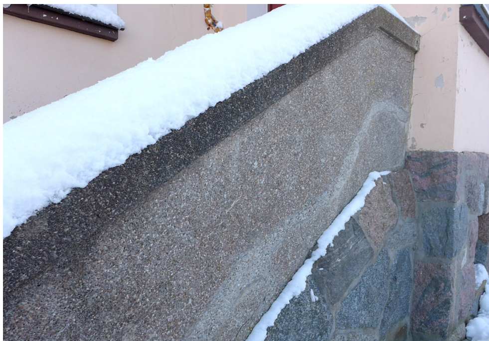
Fot. 11. Zagaje, elewacja zachodnia, widoczne uzupełnienia na lastrykowej balustradzie.
