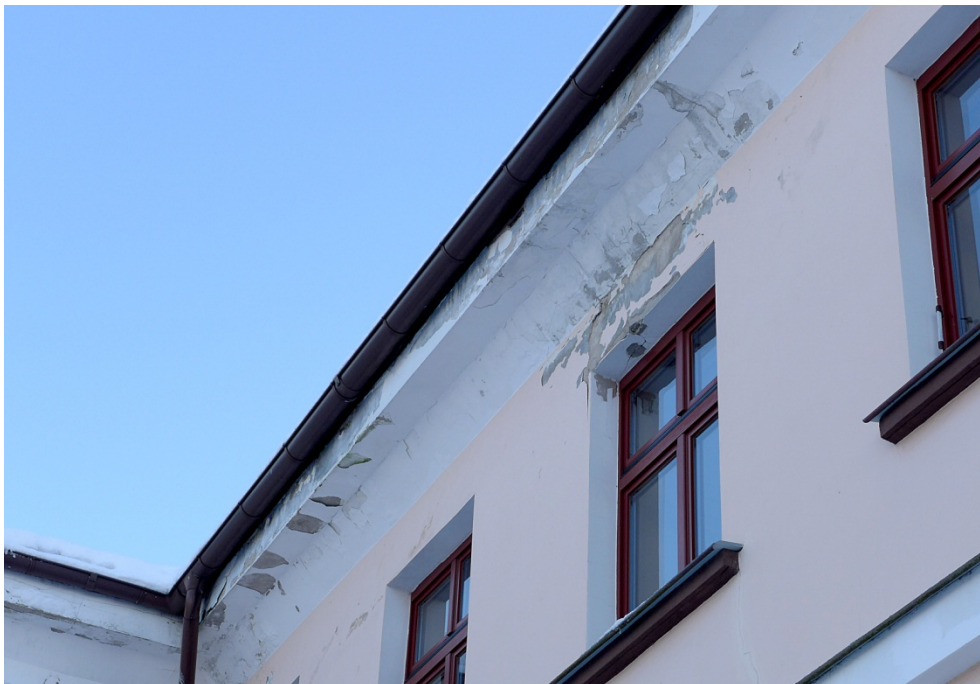
Fot. 1. Zagaje, elewacja północna, widoczne uszkodzenia elewacji i gzymsu wieńczącego, odspojenie nawarstwień spowodowane zaciekaniami wody opadowej.
