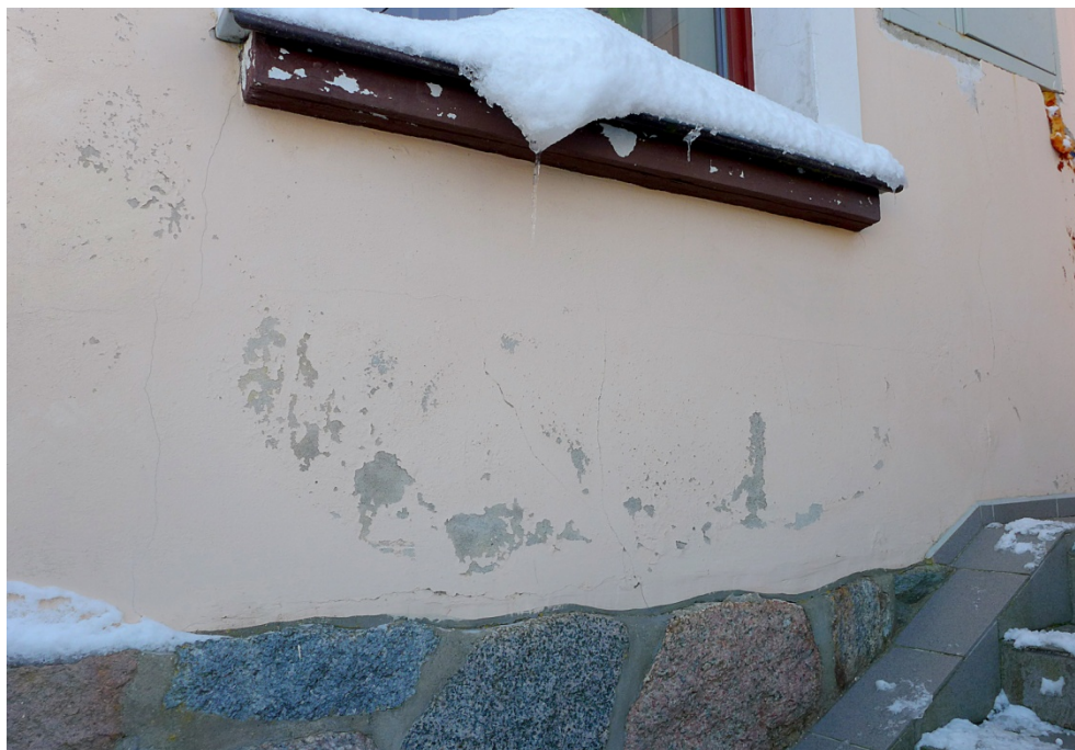
Fot. 9. Zagaje, elewacja zachodnia, widoczne odspojenia warstw malarskich spowodowane zawilgoceniem i zasoleniem wypraw tynkarskich.
