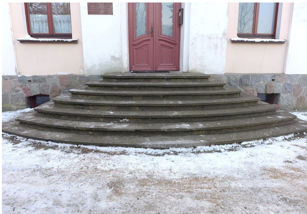
Fot. 4. Zagaje, elewacja północna, widok ogólny na główne schody, które pokrywa gruba warstwa patyny oraz wykwity mikroorganizmów. Tą sytuację ułatwia bardzo porowata powierzchnia stopnic.
